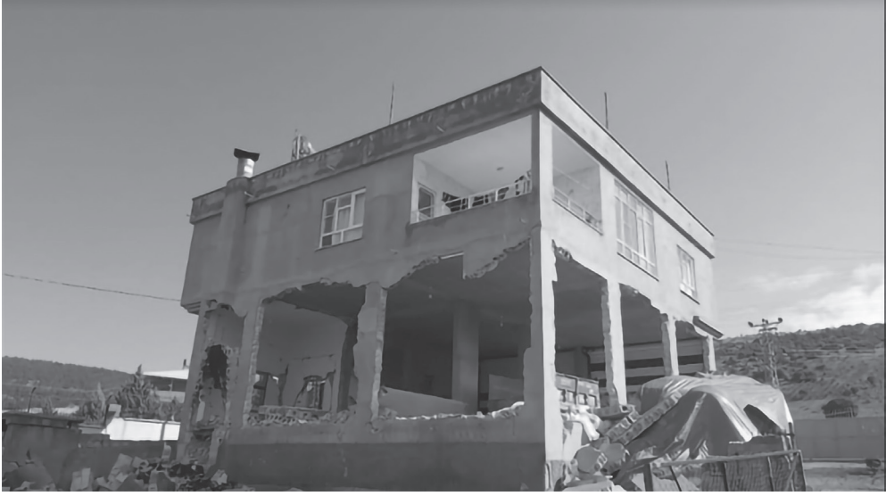
Gaziantep ili Nurdağı ilçesi deprem sonrası hasar almış duvarlar ve yumuşak kat düzensizliği
